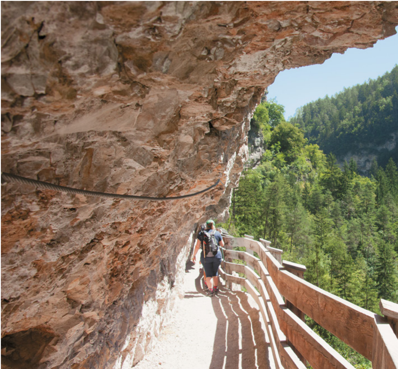
Passerelle all'interno del canyon Rio Sass
