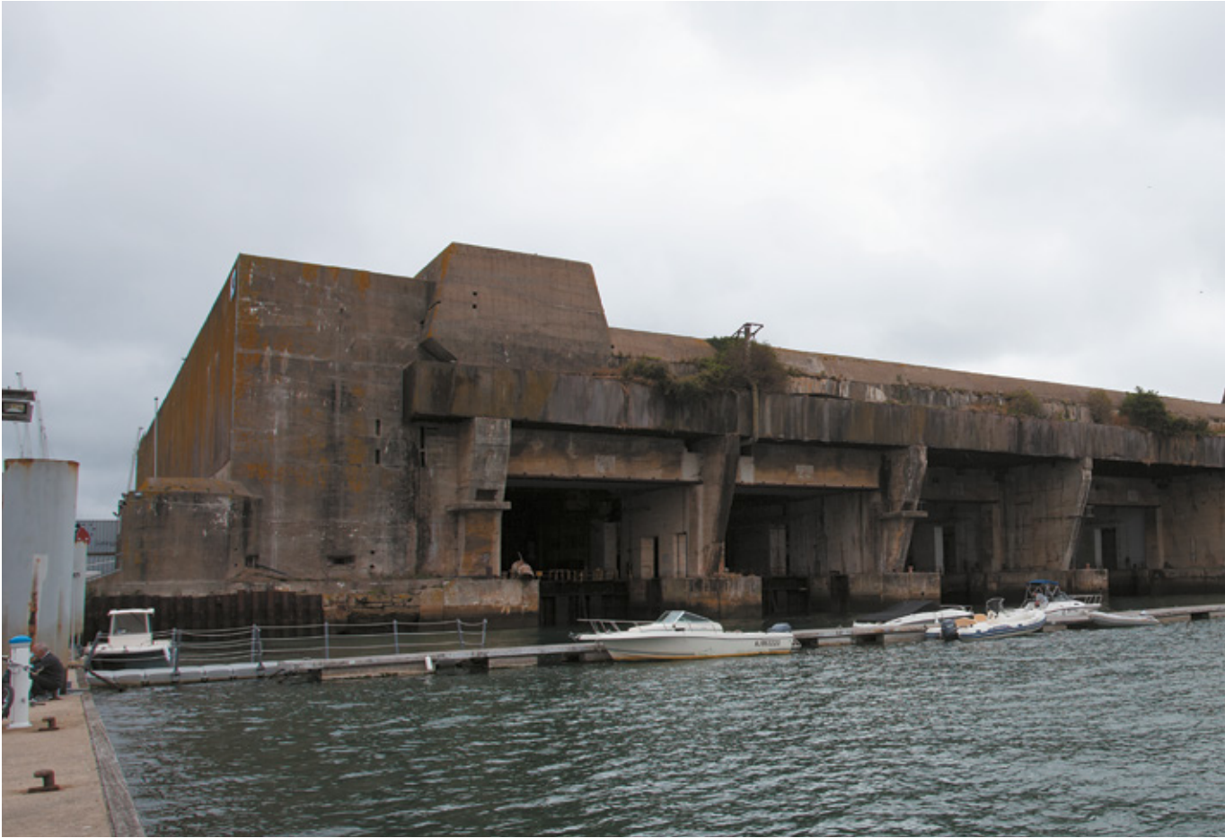
Uno dei bunker della base di Lorient
